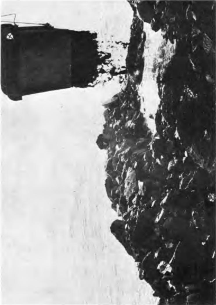
Figure 5. SAND BITUMEN BEING PLACED IN BREAKWATER
